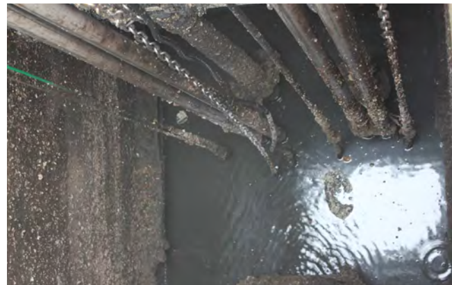
Po lewej, pompownia ścieków przed montażem systemu Flygt Concertor™ oraz dwa tygodnie po jego instalacji (po prawej).
